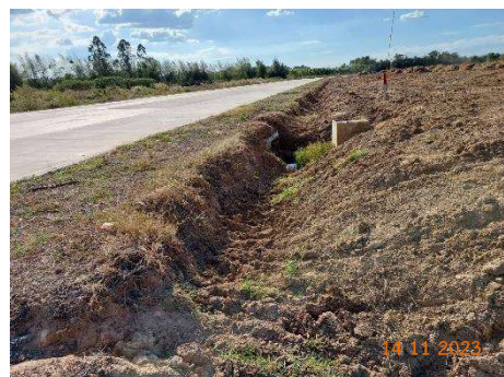
รูปที่ 2-18 การขุดลอกรางระบายน้ำ
