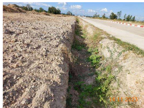
รูปที่ 2-4 รางระบายน้ำฝนในพื้นที่ก่อสร้าง
